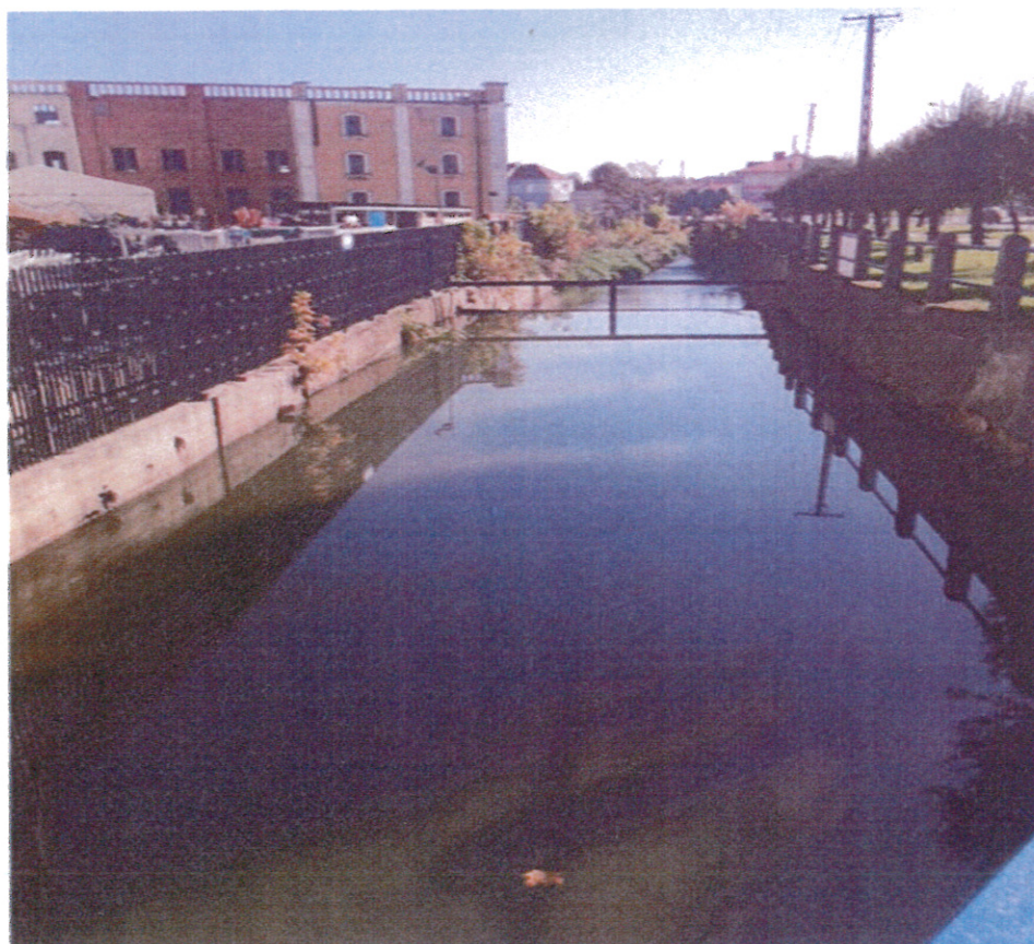
Fot. Nr 8 Jaz szandorowy na rzece Małoszówce, widok od strony spiętrzonej wody
