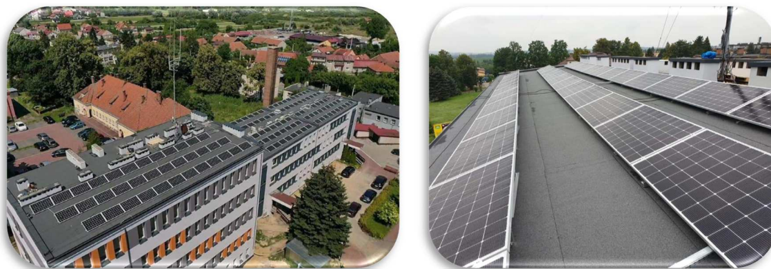
Rys. 50. Panele fotowoltaiczne na budynkach Gminy.
