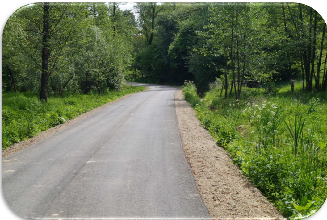
Rys. 17. Droga gminna po remoncie w miejscowości Łękawa.
