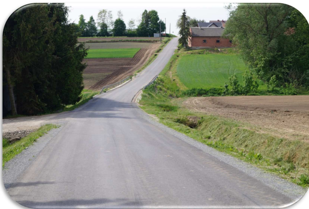
Rys. 14. Droga gminna po remoncie w miejscowości Gunów Wilków.
