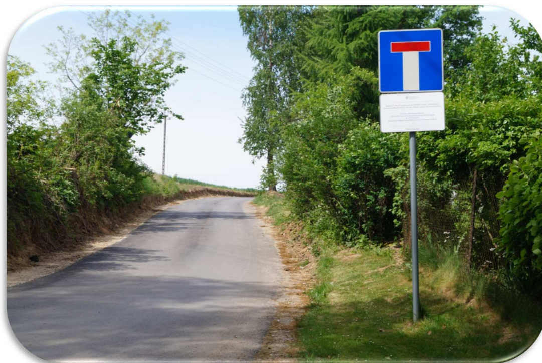
Rys. 16. Droga gminna po remoncie w miejscowości Boronice.
