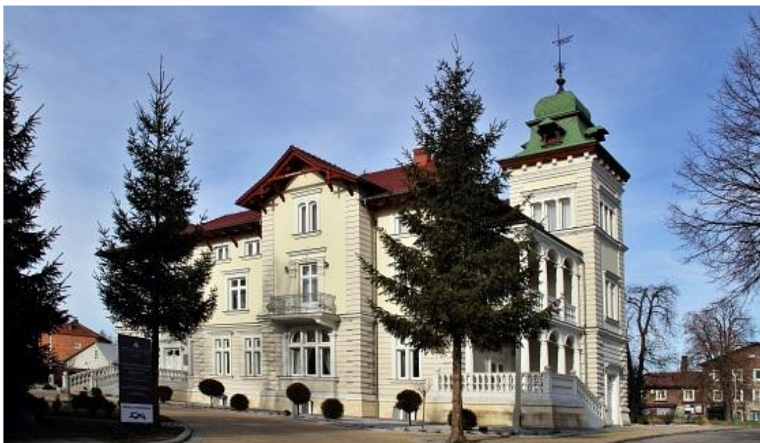
Ryc.17 Willa właściciela cukrowni po remoncie
