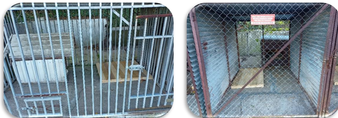
Rys. 44. Zmodernizowane kojce w Gminnym Punkcie Czasowego Przechowywania Zwierząt przy ul. Budzyńskiej 2.
