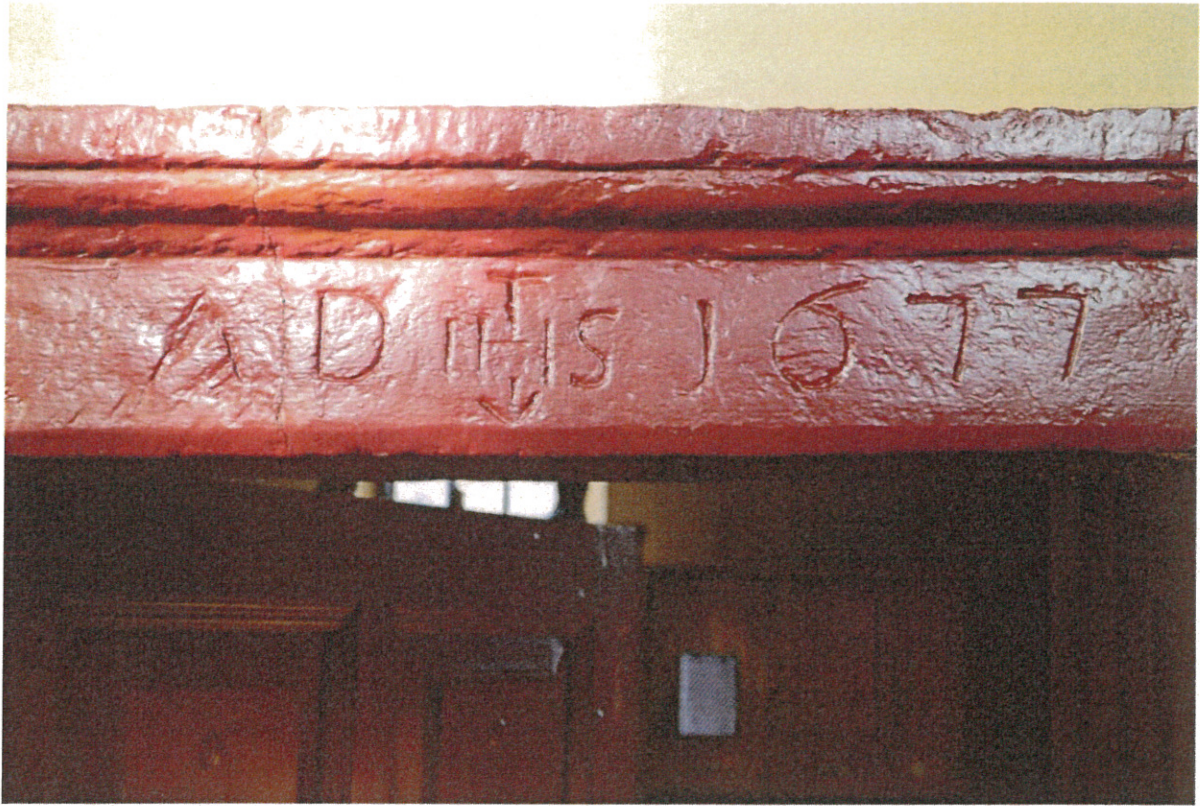
Fot. 47. Kazimierza Wielka, kościół pw. Podwyższenia Krzyża Świętego, wejście do zakrystii, kamienny portal - fragment, XIX w. stan z 09.12.2022 r. Fot. K. Głazik
